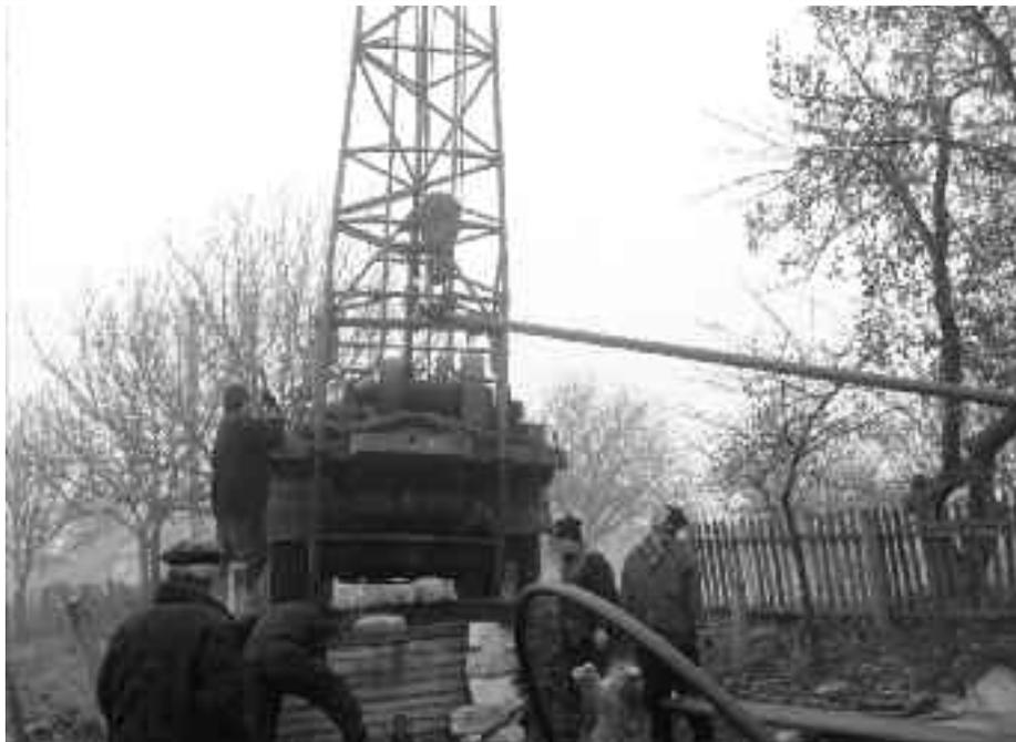
■ Unsere Wasserbohrung für den Tiefbrunnen in Cigirleni. Der Bohrturm fasst mit seinem Kran gerade die nächste Steigeleitung. Die Bohrung hat ihre endgültige Tiefe von 230 Metern erreicht. Wir sind froh, vor dem unmittelbar eintretenden Winter und Schneefall die Bohrung niedergebracht zu haben.
